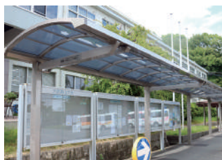
本館前に設置されたバスシェルター
